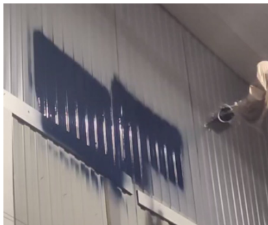
Рис. 7. Тестирование системы окраски на стене ангара. Было окрашено две области для достижения окончательного результата.
